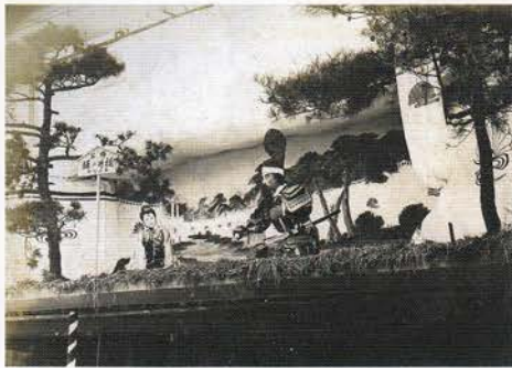
桜井の駅 (東二階町)
